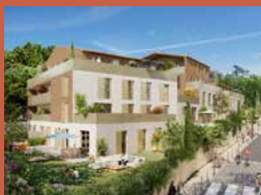
Collection Pigonnet - Aix-en-Provence (13) Maître d'œuvre : Atelier Archi2
